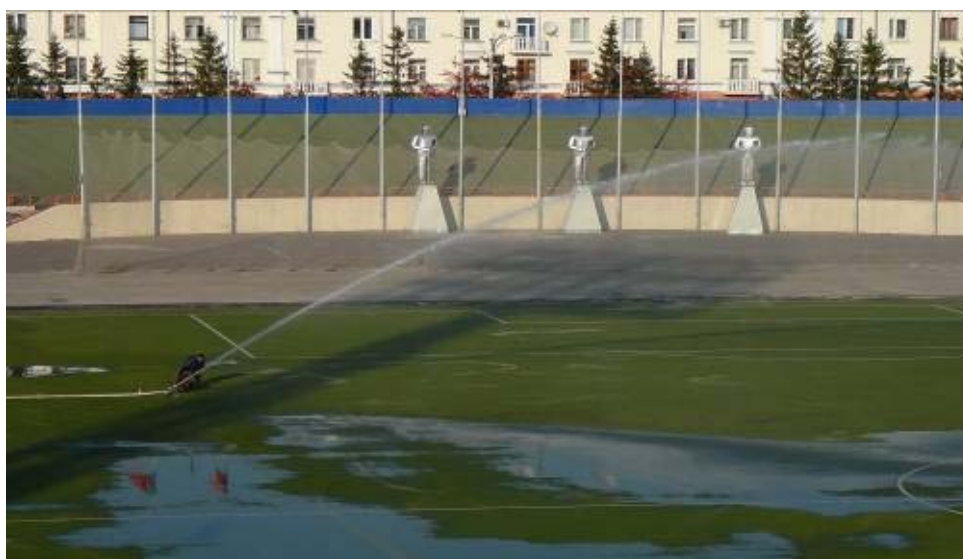
Фото 2. Пропитка искусственного коврового покрытия по секторам
