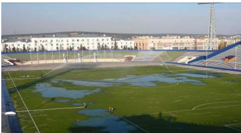
Фото 1. Лафеты выставляют так, чтобы вся поверхность поля была захвачена струёй воды
